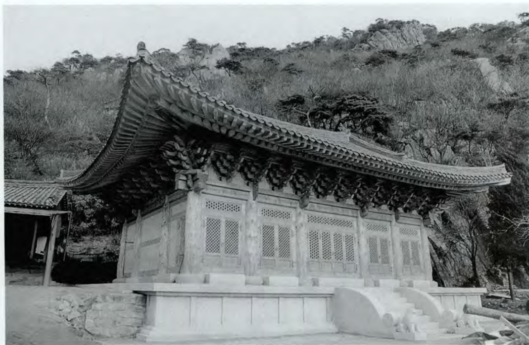
사진 4. 新築중인 大雄殿
