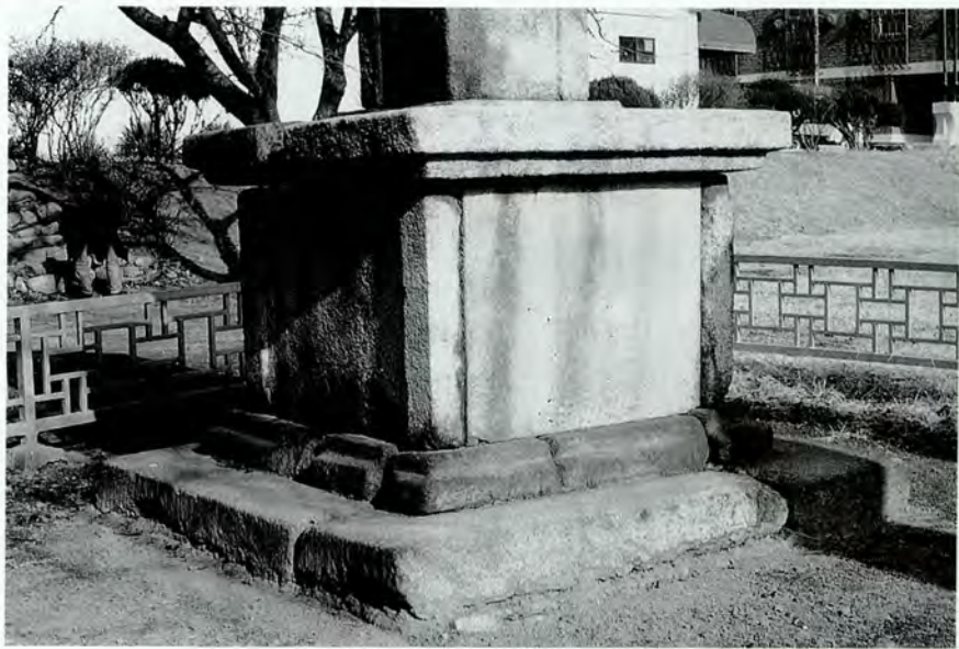
사진 6. 중초사지 3층 석탑 기단부
