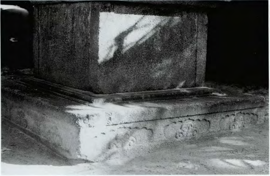
사진 13. 極樂殿 앞 三層石塔 下層基壇
