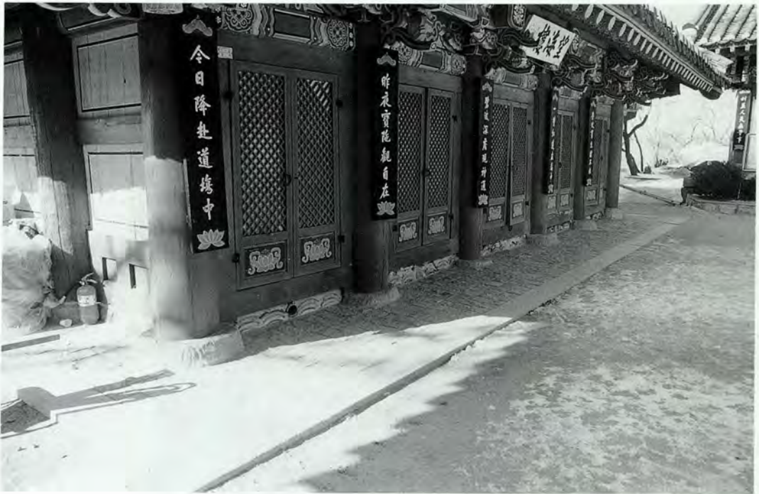
사진 8. 望海樓 前面 礎石
